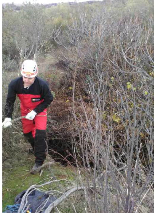
Vista del hundimiento desde el exterior.
