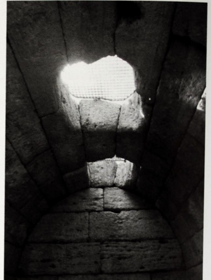
Figura 4. Techos del aljibe con los citados óculos para facilitar la iluminación interior
