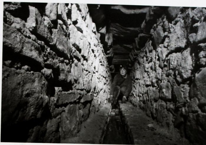
Figura 6. Interior de la galería
