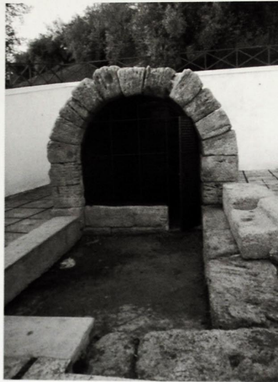
Figura 3. Entrada del aljibe
